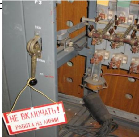
3. Проверить отсутствие напряжения в фазах и в нуле, проверить работу защиты электрических цепей, которые
